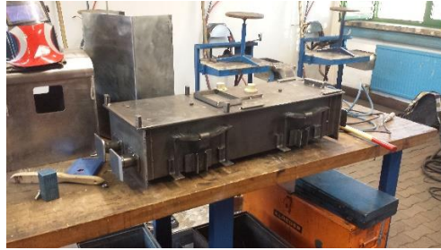
Abbildung 6: Bau des Lok-Unterbaus
