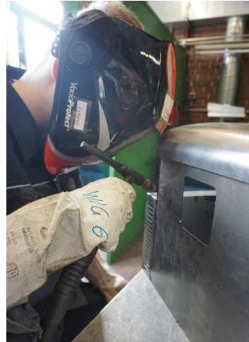
Abbildung 4: Schweißarbeiten an der Fahrkabine
